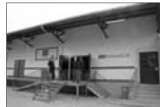
Kühlhaus, Mühlendamm 25 www.kuehlhaus.net
