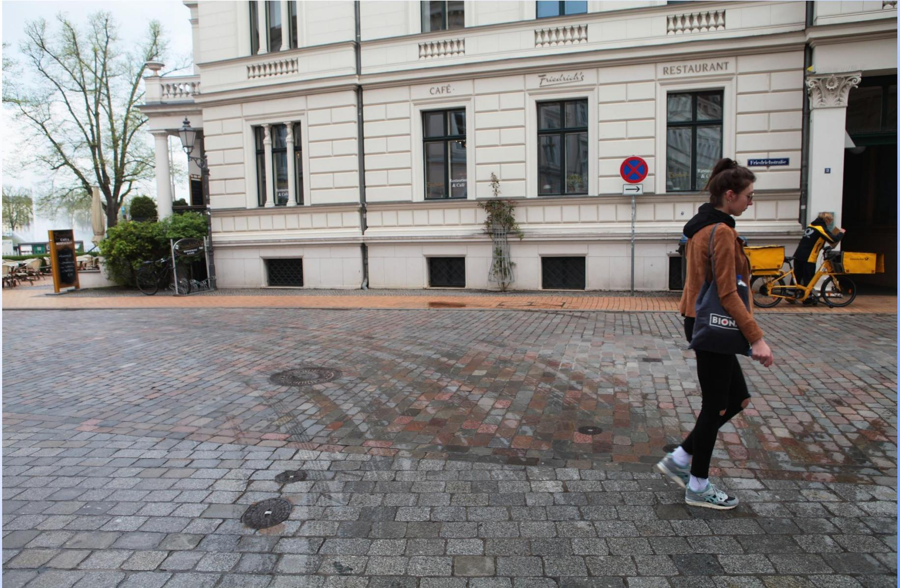
Großstein-Granit: Beispiel Schwerin. Gesägte Granitsteine mit ebener Oberfläche, mit Pflastermörtel verfugt.
