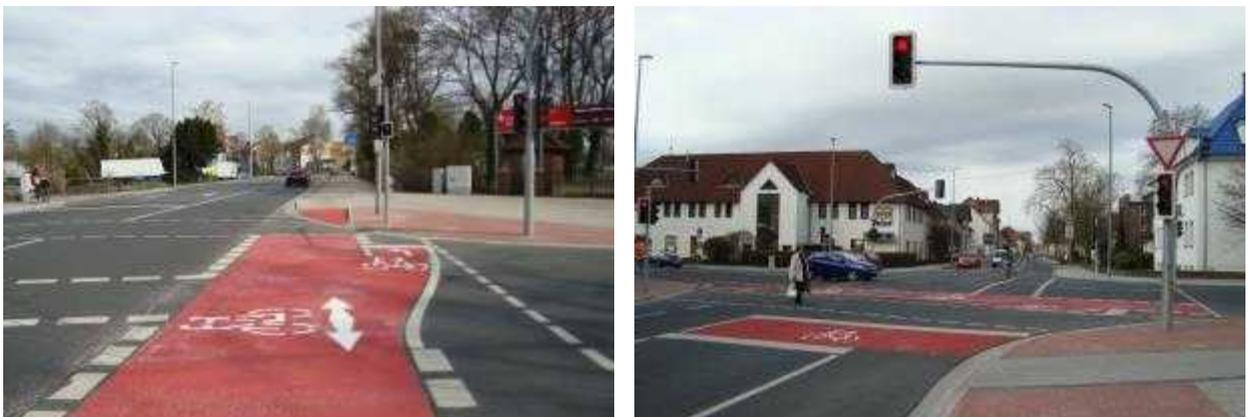
Abb. 37 Beispiel für direktes Linksabbiegen (links) und einen aufgeweiteten Radaufstellstreifen (rechts – Burgdorf, Region Hannover)
