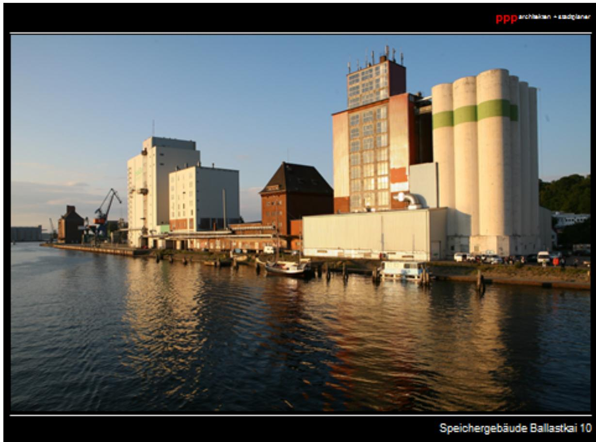
Bei dem 1936 errichteten Objekt Ballastkai 10 handelt es sich um einen fünfgeschossigen Getreidespeicher mit 24 Silozellen. Der Eisenbetonbau wurde in roter Klinkerverblendung mit steilem Walmdach errichtet. Die Fassade erhielt einen Fries in spätexpressionistischer Manier aus hochkant-übereckgestellten Läufern und schiffsbugartig vorkragenden Ziegelkonsolen.
